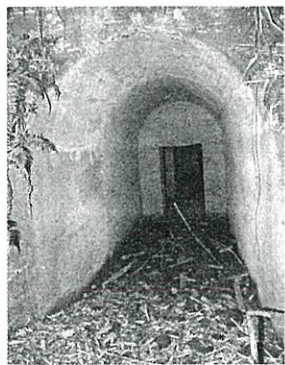
発電所壕の人員入り口
