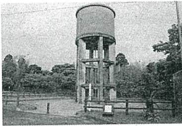
知覧飛行場高架水槽 (南九州市指定文化財)
