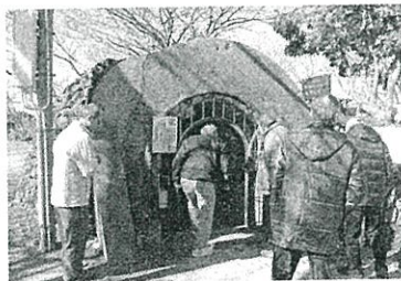
出水海軍基地戦闘指揮所地下壕(出水市文化財答申中)
