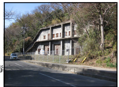
荒尾二造の戦争遺構・変電所跡
