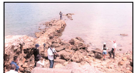
□第3回戦争遺産の旅 天草海軍航空隊半壊「スリップ」跡での見学様子。当日は大潮干潮時で、スリップ側面の擁壁が露出、基礎の松材や敷設コンクリートパネルが確認できた。
