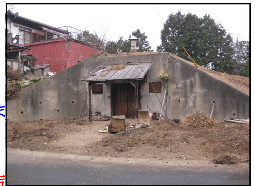
荒尾二造 小型火薬庫：崖面設置型
