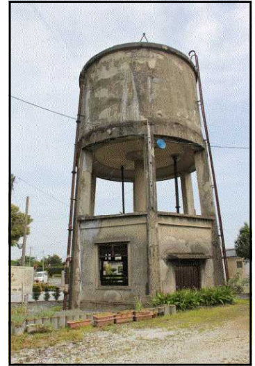
□ 熊本県菊池市指定文化財「花房飛行場給水塔」
