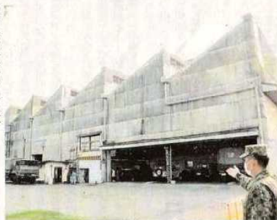
陸上自衛隊健康軍駐屯地内にある三菱重工業熊本航空機製作所第一組立工場の建屋 ＝2020年8月、熊本市東区（中島忠道）
