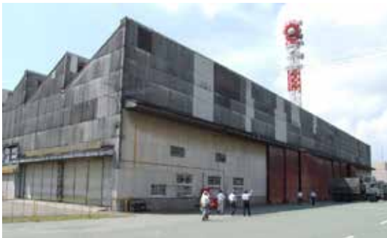
三菱重工業熊本航空機製作所第一組立工場跡
