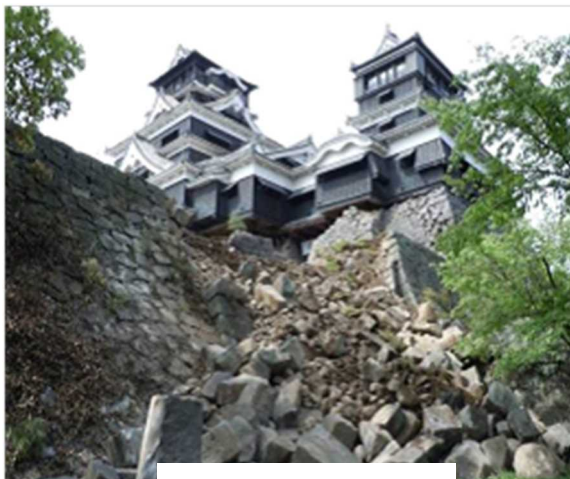
石垣の崩れた熊本城
