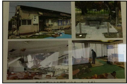
□平成28年熊本地震被害、全壊した旧広報資料館
