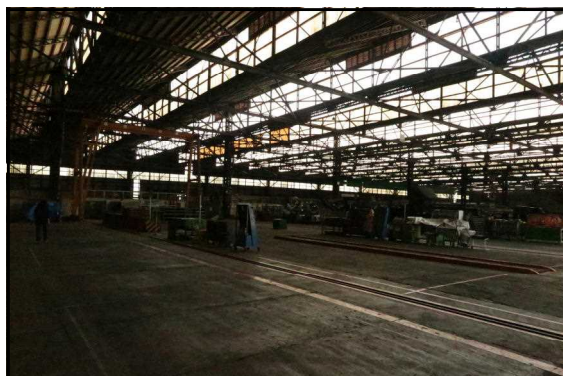
□第1組立工場内部
