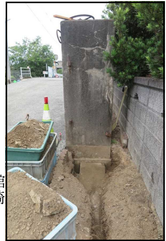
⑩大浜飛行場左正門で確認されたコンクリート製基礎遺構 2021年7月4日
