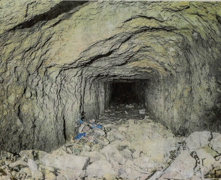
入り口が露出していた2基目の地下壕。側面に坑木設置跡が確認された(くまもと戦争遺跡・文化遺産ネットワーク提供)
