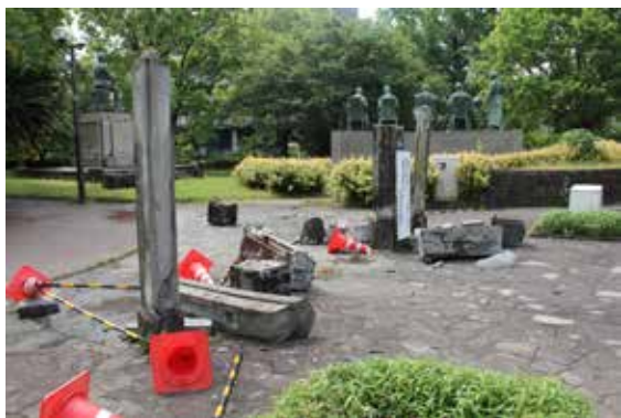
熊本市中央区高橋公園内の「第六師団長官舎門」倒壊状況
