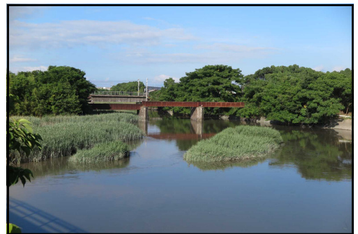
□宇城市松橋町「永代橋梁」の遠景
