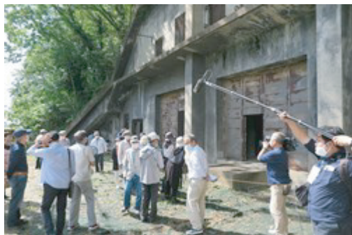
⑨めぐる旅：9/27・変電所
